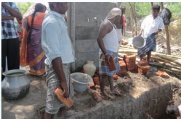
地域でのトイレ建設の様子
